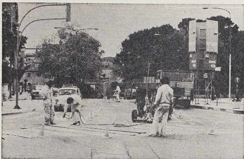
Radovi na signalizaciji gradskih prometnica
