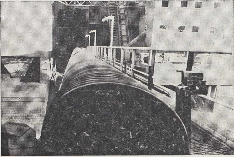
Konstrukcija mosta i transporta koji spajaju sinter i pogon ferolegura
