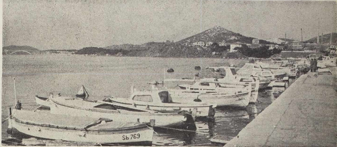
Pogled na novoizgrađeni dio obale u Docu
